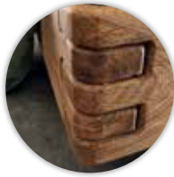
Bettrahmen mit 2 verschiedenen Eckverbindungen
